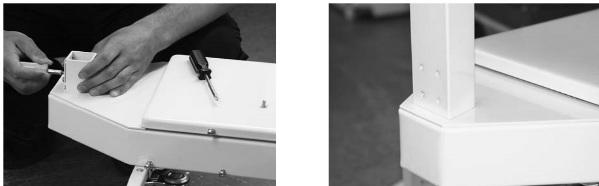
Figure 4. Retirer les vis de la base de la balance et insérer le pilier et la traverse de pesée dans la base de la balance
